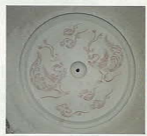
型押しの際の様子。半乾燥の型に模様を書いた和紙を張り、鑄で模様を浮き出させるように押していく。
