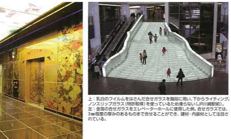
上: 乳白のフィルムをはさんだ合せガラスを階段に用い、下からライティング。ノンスリップガラス(特許取得)を使っているため滑らない(JR川崎駅前)。左: 金箔の合せガラスをエレベーターホールに使用した例。合せガラスでは、3mm程度の厚みのあるものまで合せることができ、建材・内装材として注目されている。
