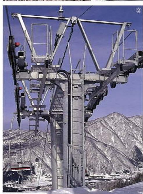
めっきは、機械・機器の部品のほかに耐食性に優れているため大型構造物でも使われている。
